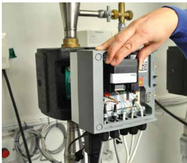
Wilo-Stratos MAXO med påmonterad CIF-modul för central övervakning via överordnat automationssystem.
