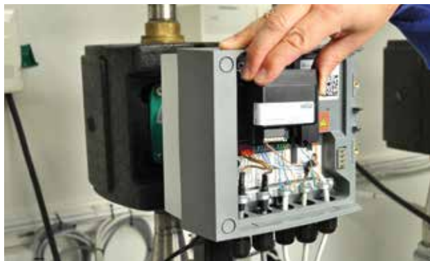
Wilo-Stratos MAXO med påmonterad CIF-modul för central övervakning via överordnat automationssystem.
